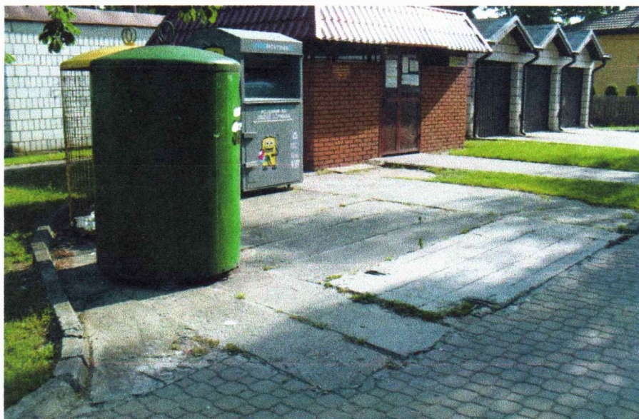
Foto: Przed remontem
